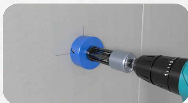
1. Tracciare la prima scatola e aprire il foro utilizzando l'accessorio per trapano PRIMO Bohr-Fixx (P779) e una sega a tazza da 74 mm (P797-74).
