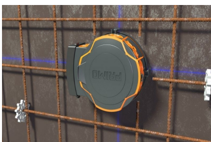
Einbaugehäuse aufsetzen. Zum Ausrichten kann es um 360° gedreht werden.
