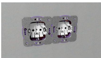
Gerät durch integrierte Schrauben befestigen.
