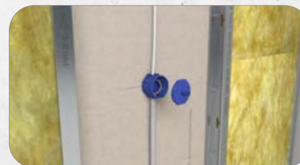
1. Klebescheibe auf die Unterseite der Multidose aufkleben und Folie abziehen. Dose an gewünschter Stelle aufkleben. Leitungen und Rohre einführen. Bohrdeckel aufsetzen.
