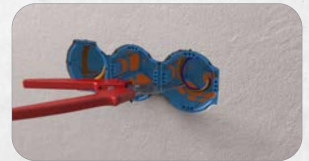
8. Bei Bedarf den SCS-Verbindungssteg ausbrechen.
