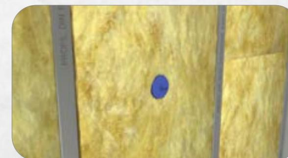
2. Dämmwolle einbringen. Option 1: Gipskartonplatte anbringen und Spitze durchdrücken. Option 2: Gipskartonplatte andrücken und mit einem Hammer ein Loch an der markierten Stelle einschlagen. Anschließend die Gipskartonplatte anbringen, sodass der Dorn durch das Loch sticht.
