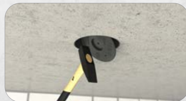
5. Nach dem Entschalen das Frontteil mit einem Hammerschlag öffnen.
