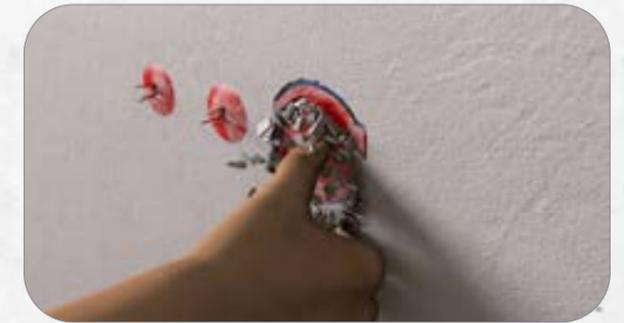
6. Putzfedern sorgen für schnelles Auffinden. Den Deckel mit dem Finger oder Schraubenzieher eindrücken. Wenn er nach außen ploppt, entsteht eine saubere Kontur ohne Sprünge im Putz. Anschließend Deckel entfernen.
