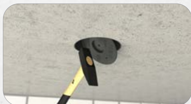
10. Nach der Betonage einfaches Öffnen der Frontteile durch Hammerschlag.
