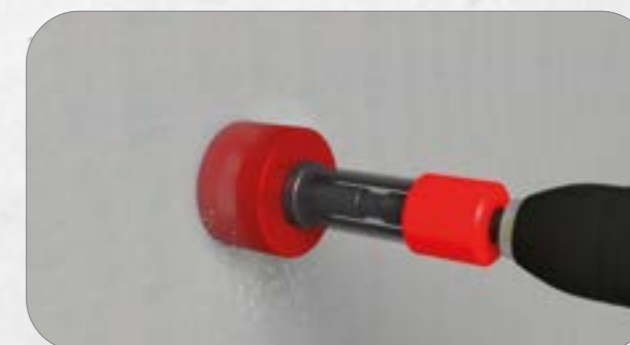
4. Dosenfräser im Zentrierbohrloch ansetzen und Loch ausfräsen.
