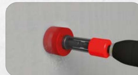
4. Dosenfräser im Zentrierbohrloch ansetzen und Loch ausfräsen.
