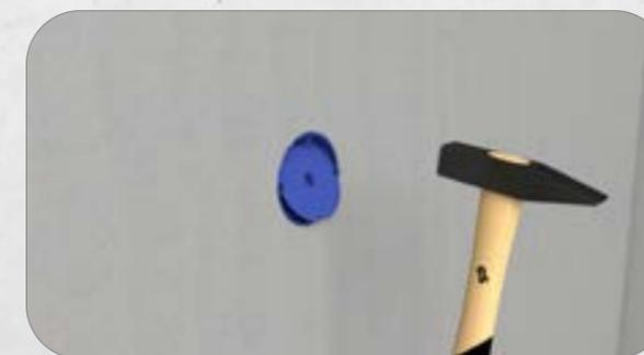
4. Deckel mit einem Hammer ausbrechen. Installation abschließen.
