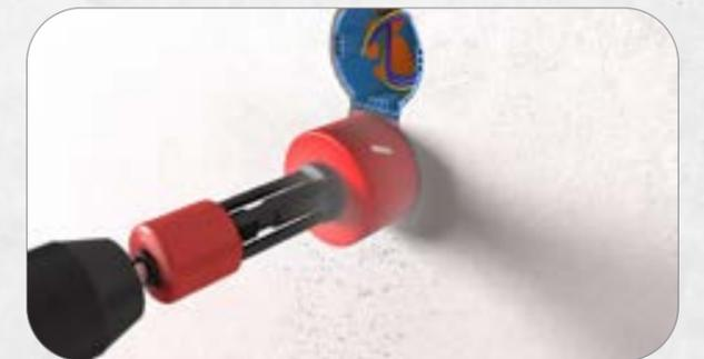
10. Alternativ den Putzdeckel mit einer 68 mm Bohrkronen freilegen und entfernen.
