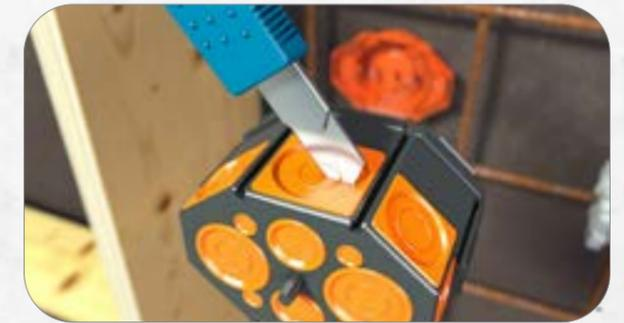
2. Membrane mit einem Cuttermesser öffnen. Großrohreführung M32.
