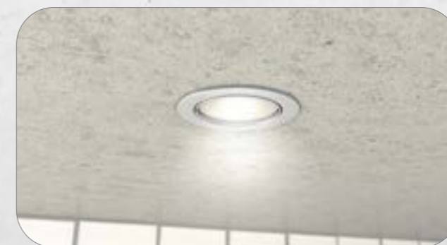
6. Beliebige Einbaugeräte wie z.B. Leuchten oder Lautsprecher installieren.
