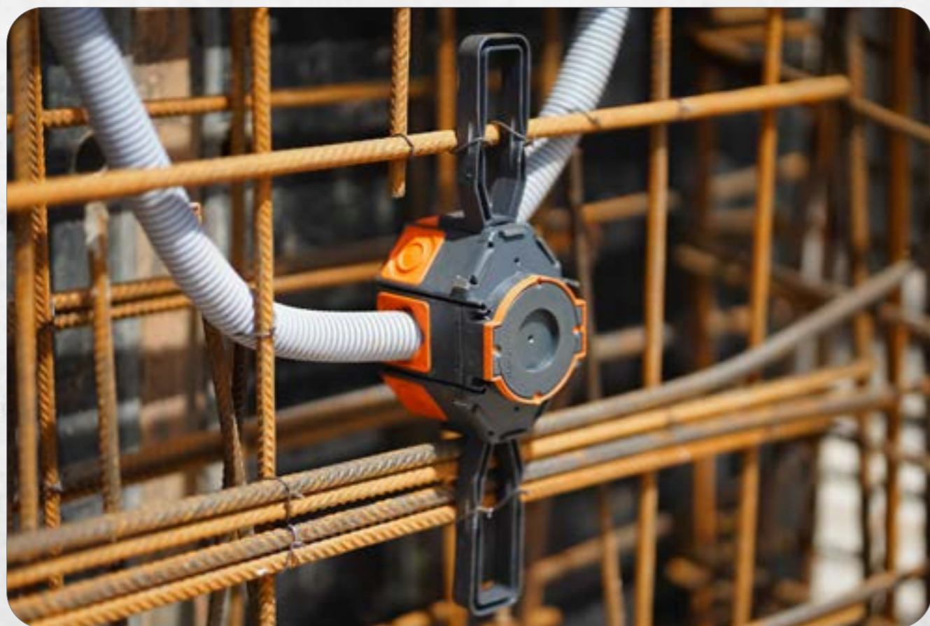
1. Flügel auf die Membrandose M1, M2 oder M3 aufstecken. Flügel geben 15 cm Normabstand zur Türschalung vor und ermöglichen eine einfache Montage. Flügel mit Draht auf der Stahlarmierung befestigen.
