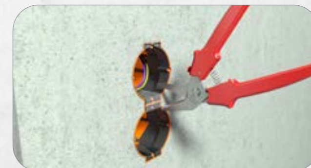
4. Bei Bedarf den SCS-Verbindungssteg mühelos mit dem Primo Dosen-cutter heraustrennen.
