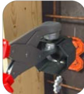
Löcher für Installationsrohre M20/M25 mit einer Stanzzange ausstanzen. Löcher für Installationsrohre M32 mit einem Stufenbohrer ausbohren. Installationsrohre einführen. M20/M25 und Großrohreinführung M32 möglich.
