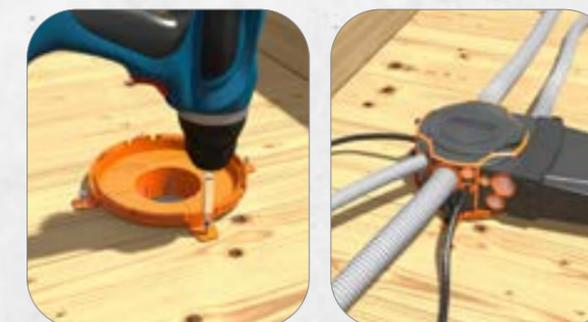
2. Uni-Flexx mit Schrauben auf der Sichtschalung befestigen. Einbaugehäuse XL 150 aufsetzen. Membran mit Cuttermesser öffnen, um Kabel und Rohre einzuführen.
