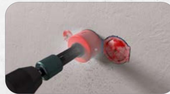
7. Alternativ den Putzdeckel mit einer 68 mm Bohrkronne freilegen und entfernen.
