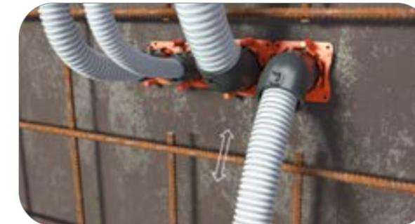
Dank Rohrgrip sicher zugentlastet und absolut betondicht.
