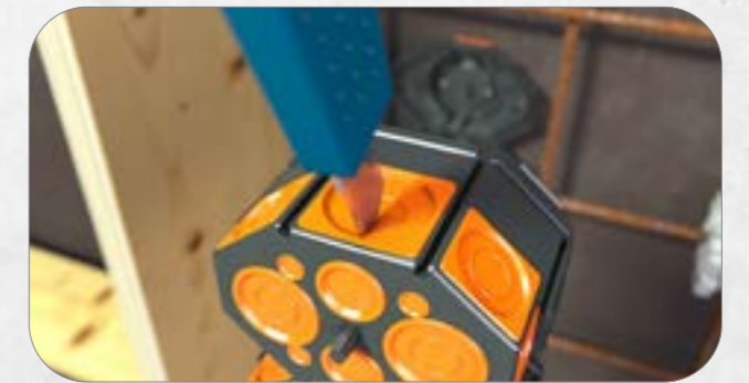
4. Membran mit Cuttermesser einschneiden.
