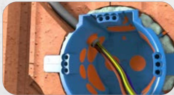
5. Kabel durch den Cable-Plopp durchstecken und so komplett werkzeuglos einführen.
