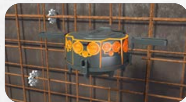
1. Aufsteckbare Flügel am Gehäuse befestigen. Flügel mit Draht an der Stahlarmierung befestigen.
