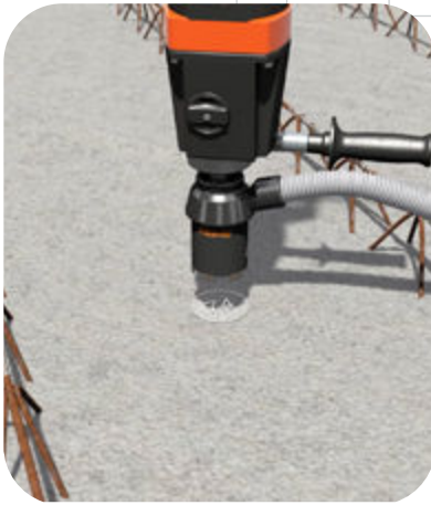
74 mm Bohrung in Filigrandecke einbringen.
