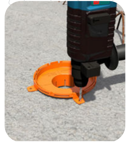
Uni-Flexx in Bohrloch stecken. Löcher durch Montagelaschen bohren und mit Schlagdübeln befestigen.
