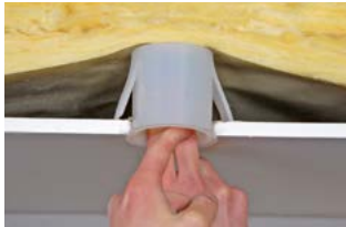
Schutzkappe in Bohrloch einschieben.
