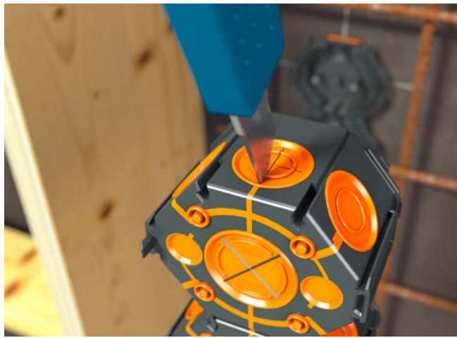
Membrane mit einem Cuttermesser öffnen.
