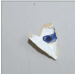
Der herausragende Mitteldorn dient als Zentrierung für die Ø 68 mm Bohrkrone.
