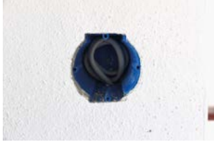
25 Sekunden für 5 Dosen ausbohren und Deckel entfernen.
