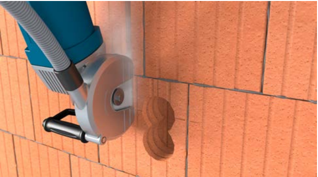
Schlitz mit Mauernutfräse entlang der Bohrungen fräsen.
