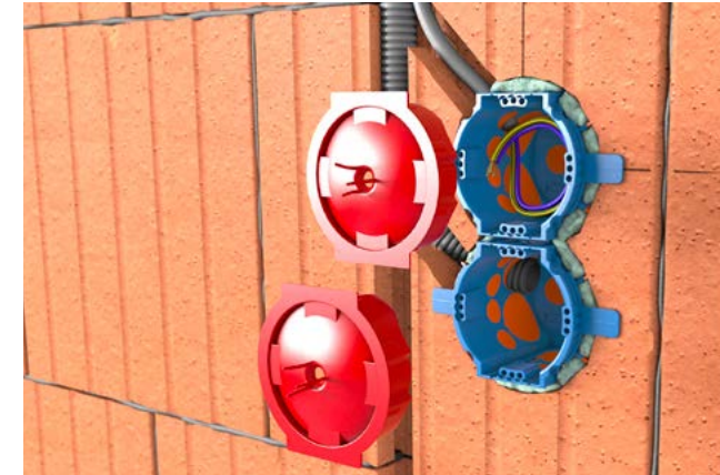
Putzdeckel aufsetzen.
