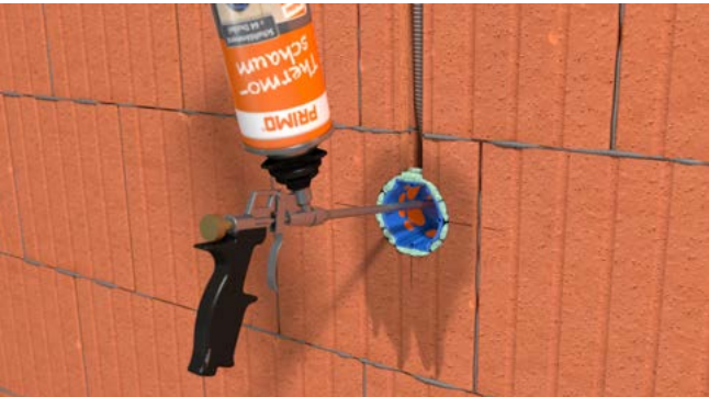
Dose setzen und einschäumen.
