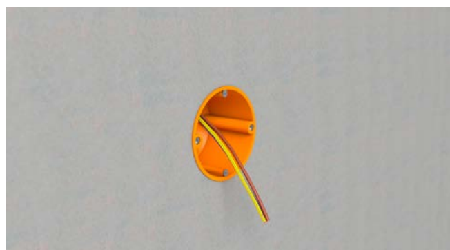
Hohlwanddose montieren und Einbaugerät/Steckdose installieren.
