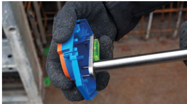
Deckel mithilfe 60 mm Aufnahmestifte aufnehmen.
