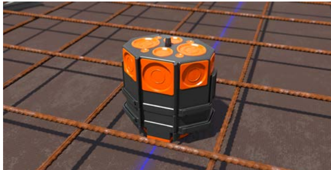
Membrandose aufsetzen und Membrane mit einem Cuttermesser öffnen.
