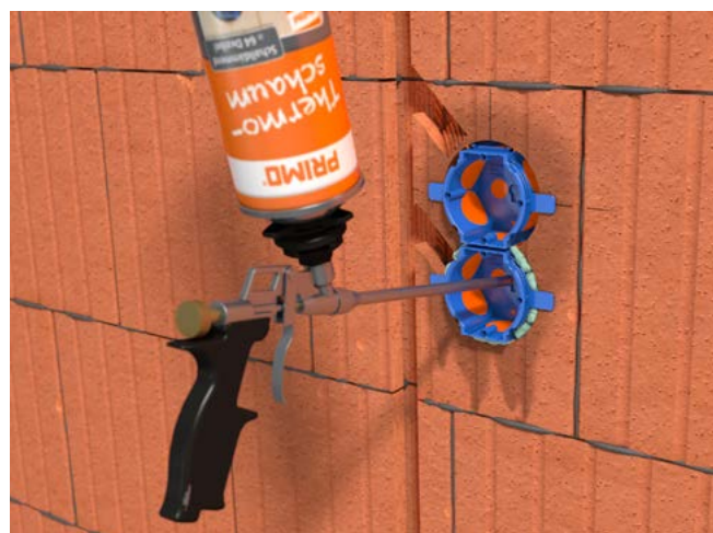
Thermodosen einschäumen.
