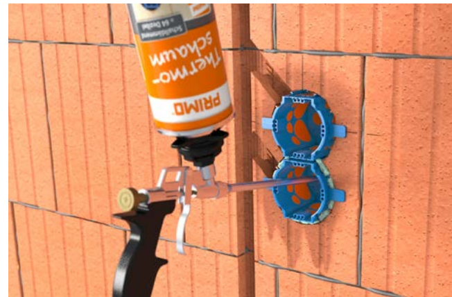
Thermodosen einschäumen.
