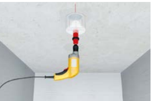
Mit einem Lochschneider wird die individuelle Öffnung ausgebohrt ...
