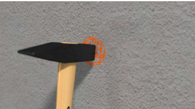
Deckel mit Putzfedern vorsichtig mit Hammer einschlagen.
