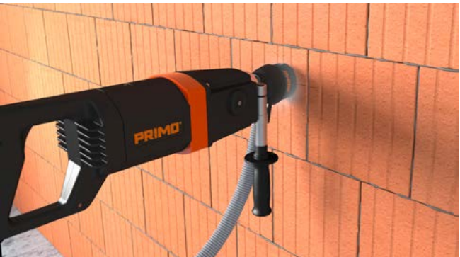
Erste Dose anzeichnen und mit Ø 82 mm Bohrkronen ausbohren.
