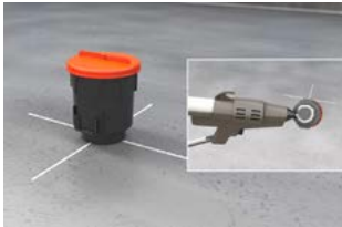
1. Variante: Mit Heißkleber auf Schaltisch kleben.
