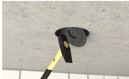
Nach dem Stellen der Gegenschalung kann betoniert werden. Nach dem Entschalen das Frontteil mit einem Hammerschlag öffnen.
