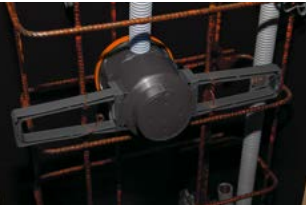
Montage als Elektronikgroßdose mit Flügeln.
