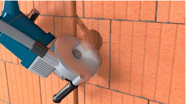
Variante 2: Schlitz bis in das Dosenloch fräsen.
