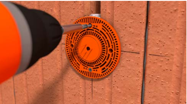
Geräteträger aufstecken und mit 2 Schrauben befestigen.
