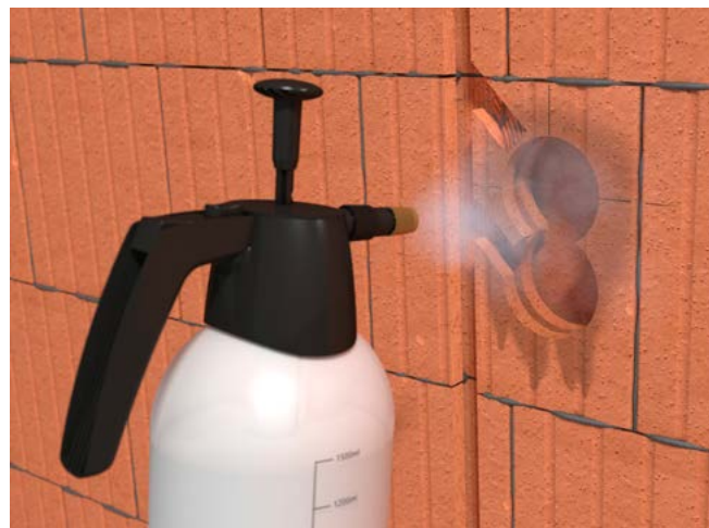
Bohrung anfeuchten, Schaum quillt dadurch noch besser auf.
