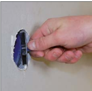
Leichtes Rausnehmen des durchfräs- ten Bohrdeckels.
