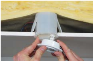
Strahler montieren.
