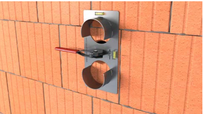
Bohrschablone ins vorhandene Loch einsetzen und ausrichten.
