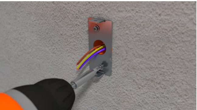
Lampenhalterung ohne Dübel durch den Putz verschrauben.
