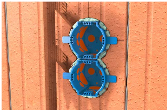
Bei ausgehärtetem Schaum den verbleibenden Steg ausbrechen.
