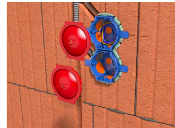
Putzdeckel aufsetzen.
