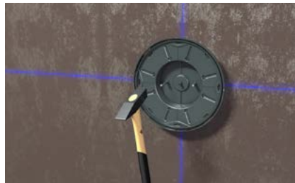
Frontteil auf der Schalung mit Nägeln befestigen. Die integrierte Nagelfixierung ermöglicht eine einfache Montage.
